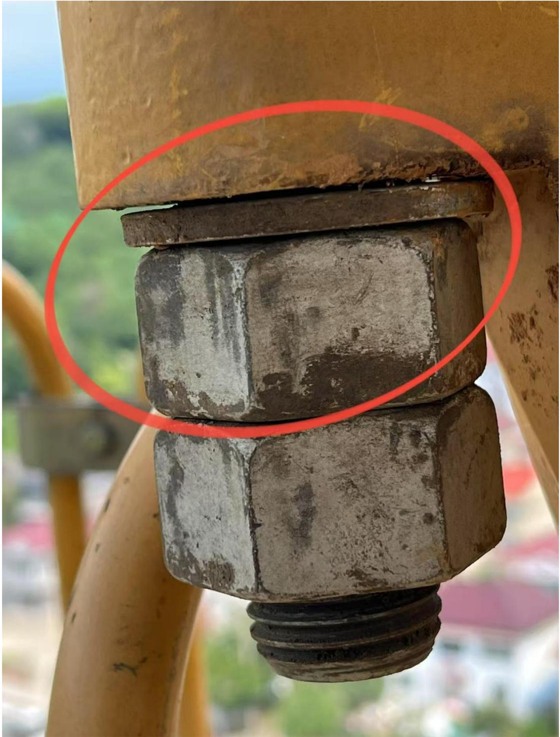
塔吊标准节螺栓松动
