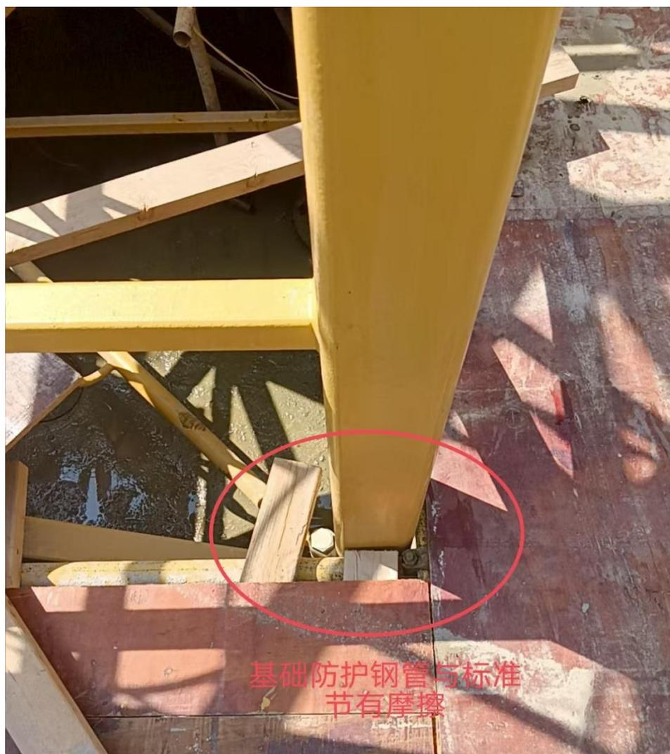
基础防护钢管与塔吊标准节摩擦
